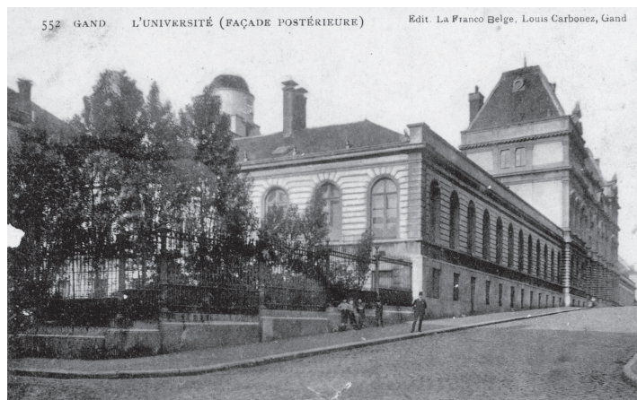
Zicht op de universiteitsgebouwen aan de Rozier
